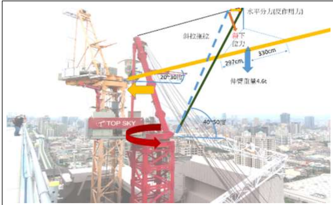
示意圖：拆除機(紅色)示意吊掛塔式起重機伸臂及旋轉情形。
