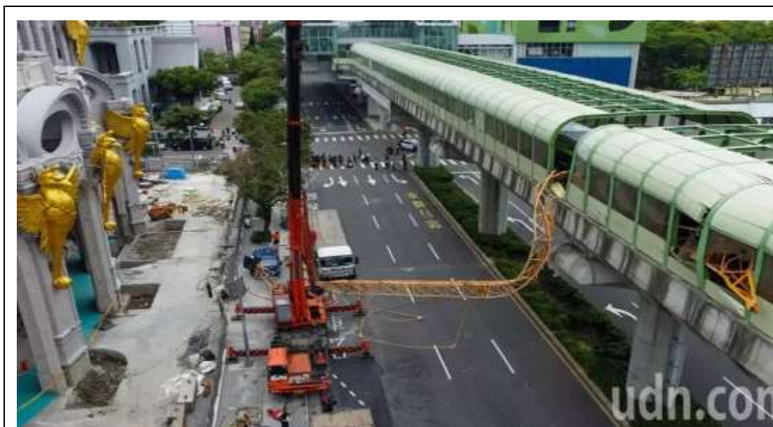
照片 3：塔式起重機伸臂掉落於文心南路並撞擊中捷軌道情形。
